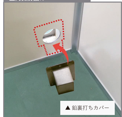
配線用貫通口 室内側防護カバー
